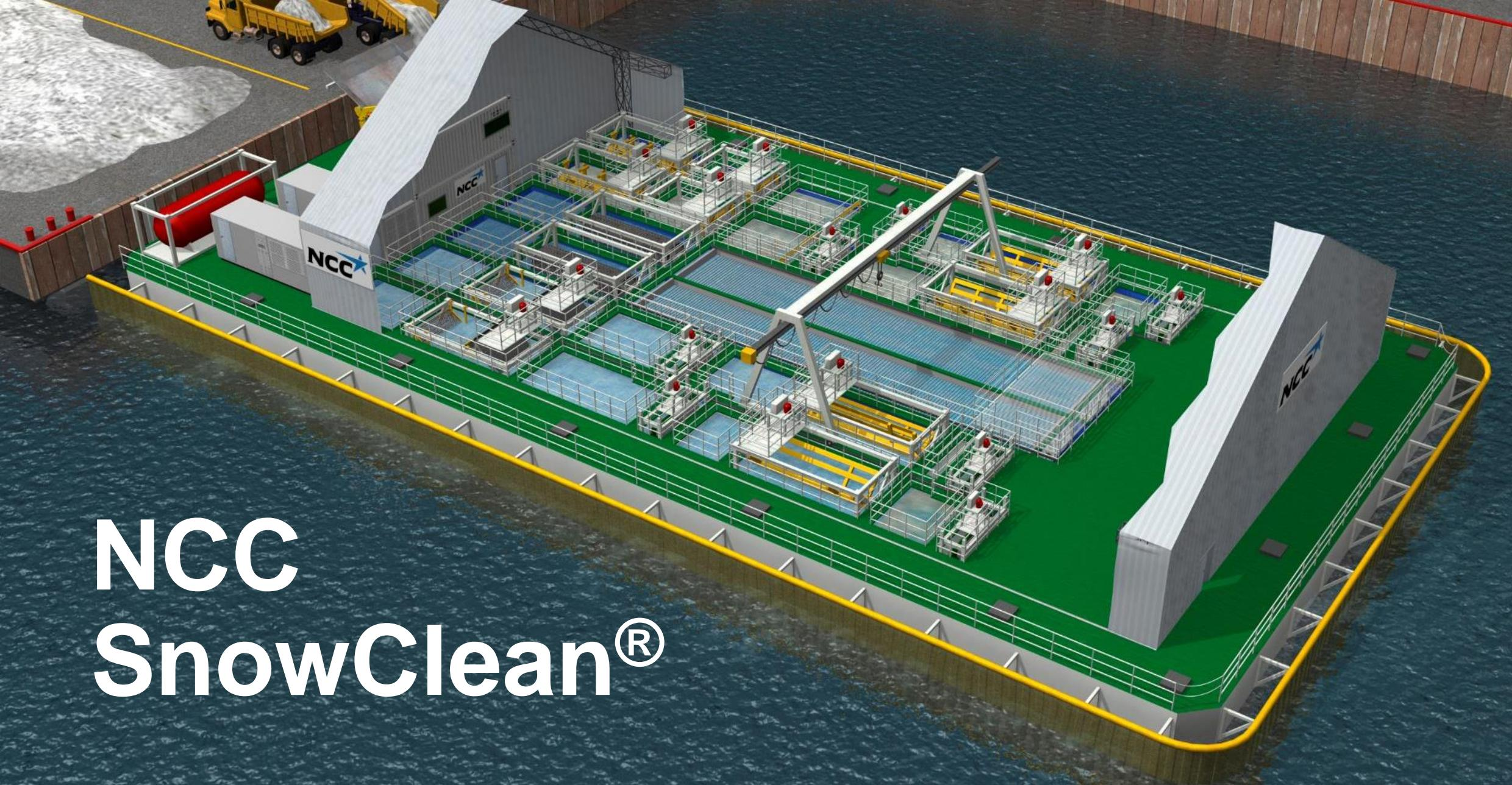
**Vi bruker varmen fra sjøvann for å smelte snøen. Parallelt med smeltingen og etter at snøen er smeltet blir avfallsstoffer renset ut i en sofistikert prosess.**
